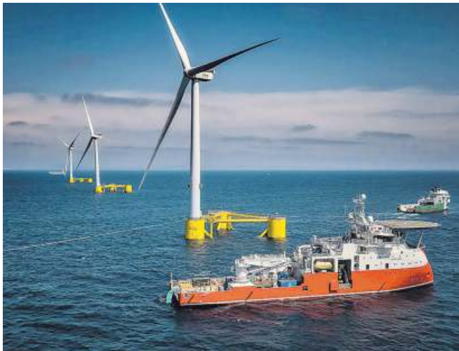
El sector energético mira ahora hacia la eólica marina. WIND FLOAT
