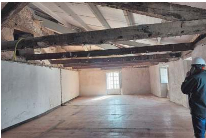
Los diseñadores de interiores trabajan en rehabilitación de viviendas. E. S.
